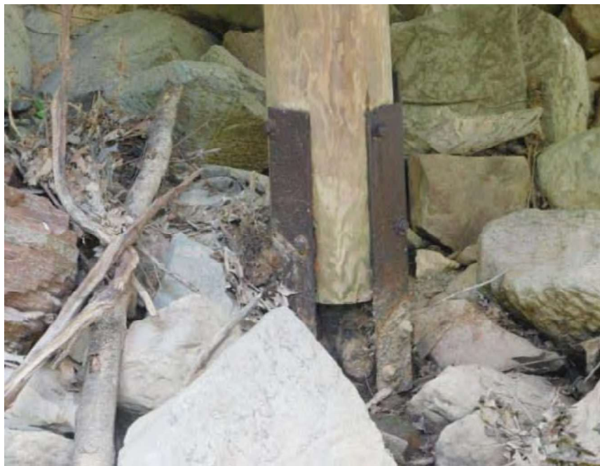
PILE B BENT 2
