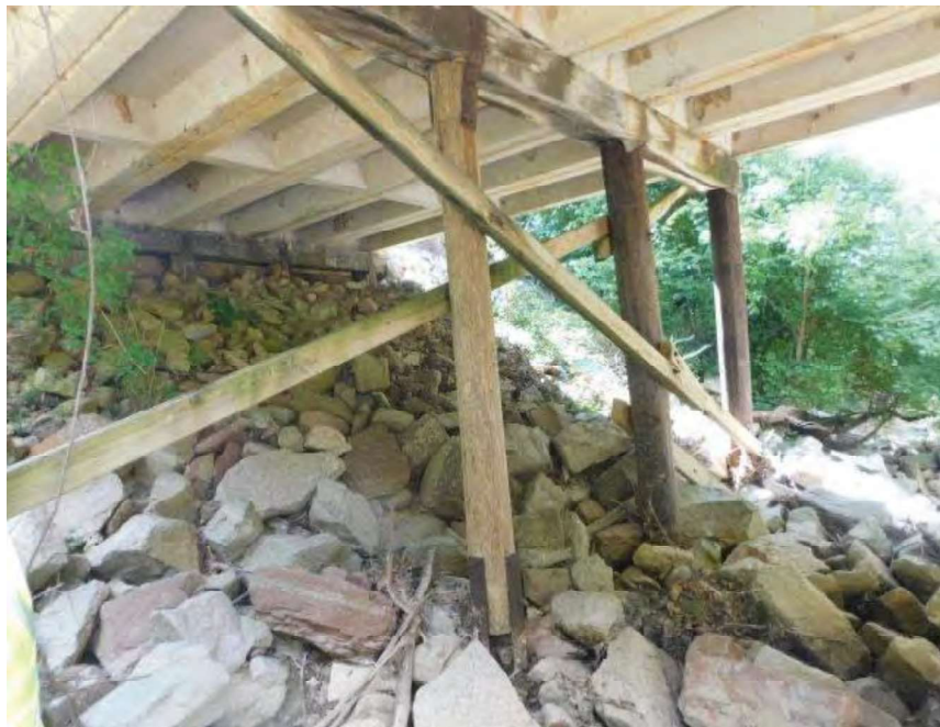
PILE B BENT 2
